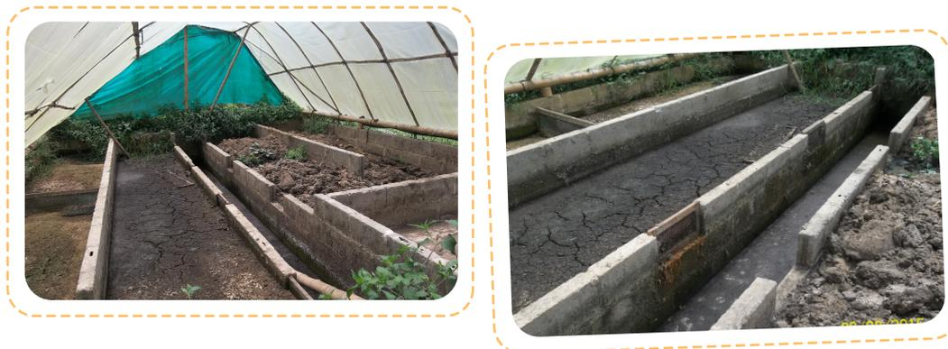
Figura 4.94.9 Tanques de secado lodos de las piscinas de engorde
